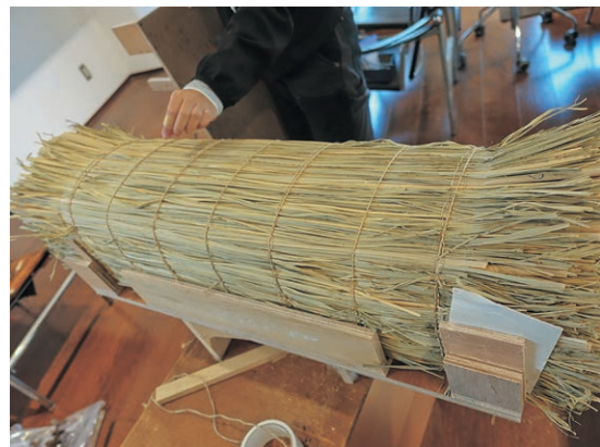
挿図28 木型で圧縮後、麻糸で7筋縛り上げる
