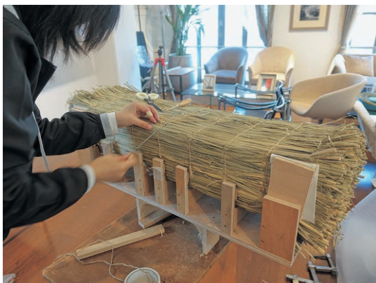
挿図29 1回目の土手差し
