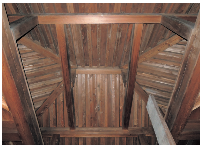
挿図20 小屋組見上げ
