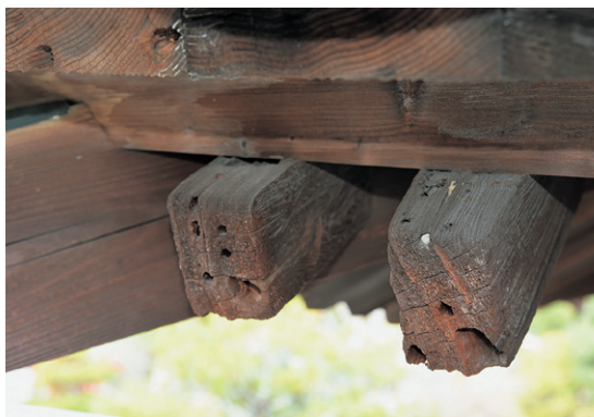
挿図23 当初の垂木先の状態
