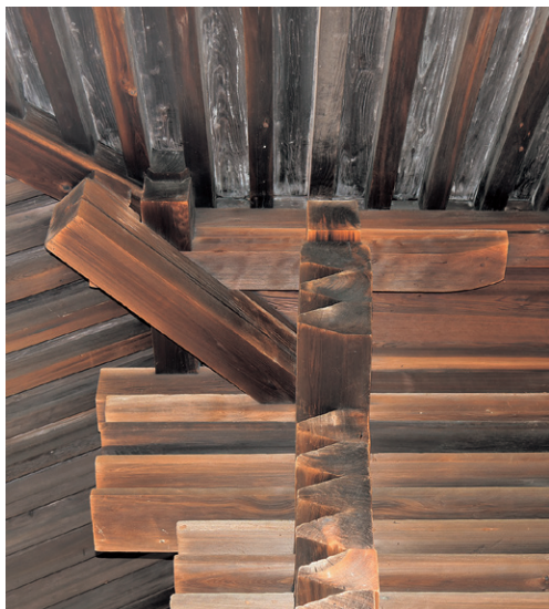
挿図22 出桁(丸桁)隅の受け方の比較 (上：正倉院正倉、下左：聖語蔵、下右：法華堂経庫)
