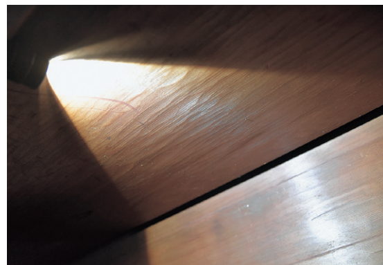
挿図30 経棚板裏の槍鉋加工痕
