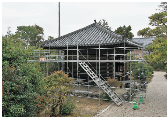
挿図1 聖語藏調査用足場設置状況
