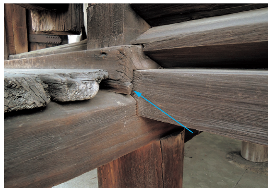
挿図10 戸口切目長押下の板材の断片
