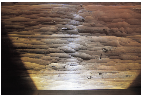
挿図16 校木内面の槍鉋加工痕
