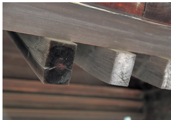
挿図24 後補の垂木先の状態 (左：明治、右：大正)
