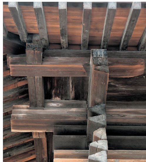
挿図22 出桁(丸桁)隅の受け方の比較 (上：正倉院正倉、下左：聖語蔵、下右：法華堂経庫)
