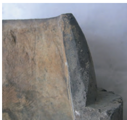
図11 鎌倉時代後期丸瓦玉縁形状
