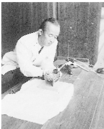
材質調査（昭和30） ベータ線後方散乱法で白瑠璃碗の測定をする 山崎文男調査員
