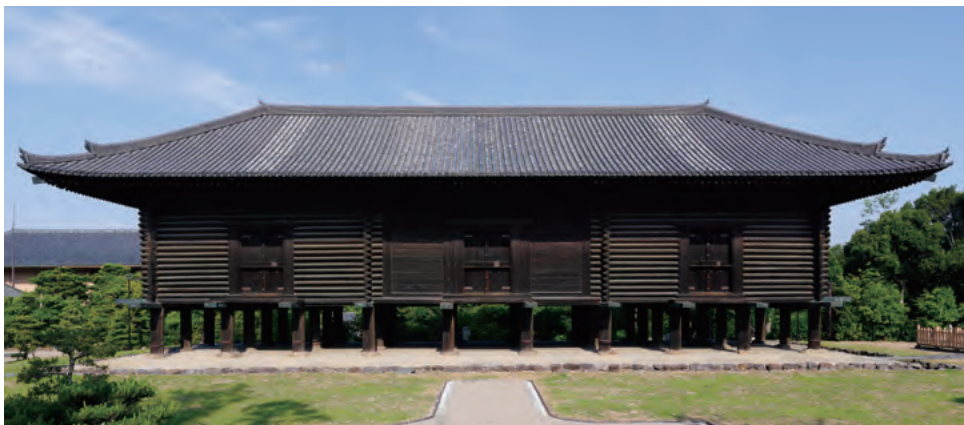
修理後の正倉 南面および東面に古い時代の瓦を再利用した(春日井「正倉院正倉整備工事の報告」参照)
